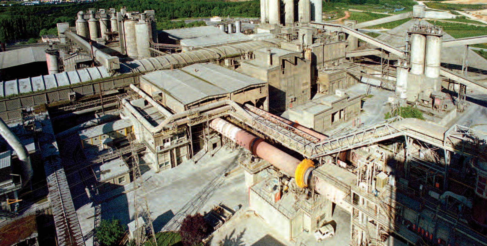
> La cimenterie d'Airvault.
