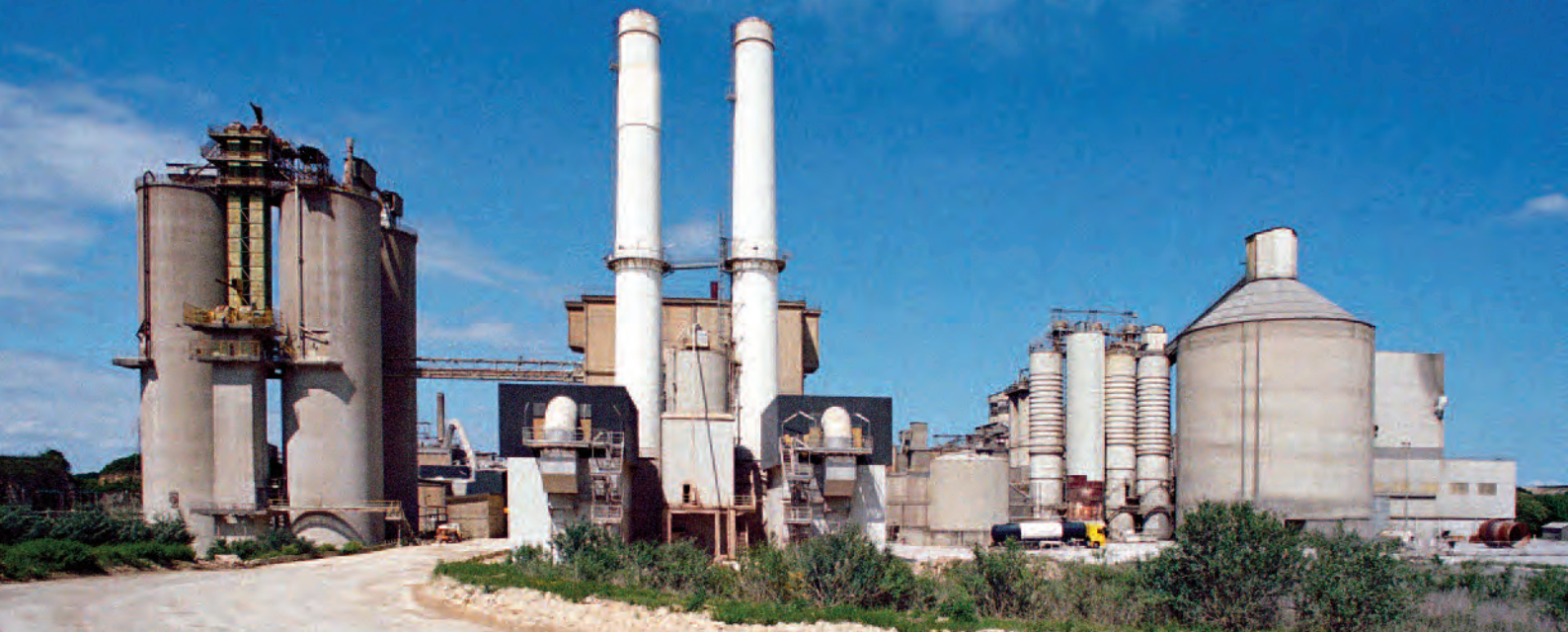
> La cimenterie d'Airvault.
